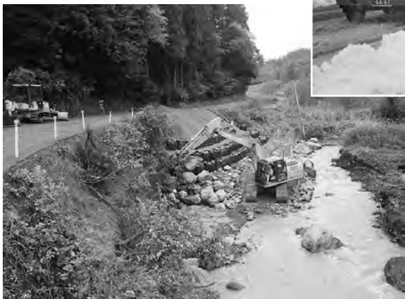
台風に伴う豪雨で崩落したのり面の復旧作業。道路が狭く輸送が不便な場所ほど、土木の力が人の生活の支えになる（2019年10月）
