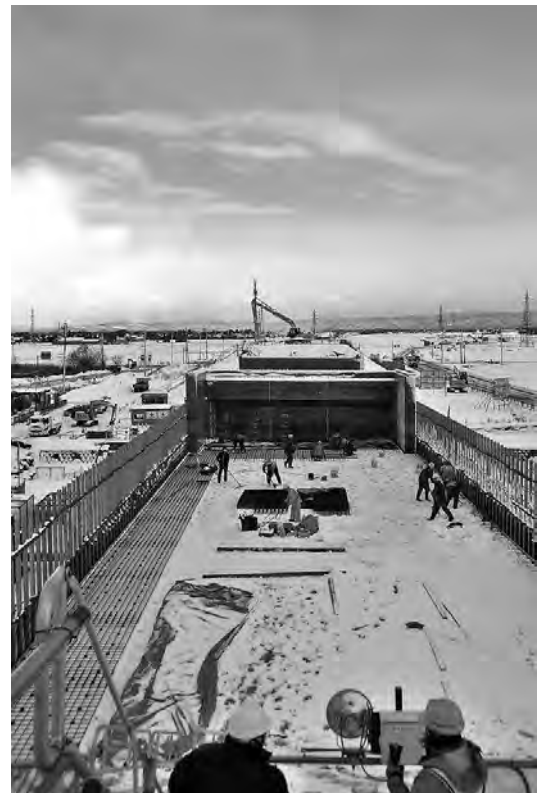
上越三和道路寺IC～鶴町IC間の道路工事。前日までに降った雪をかき分け、発泡スチロールブロックによる盛土工事が進んだ（2017年12月）
